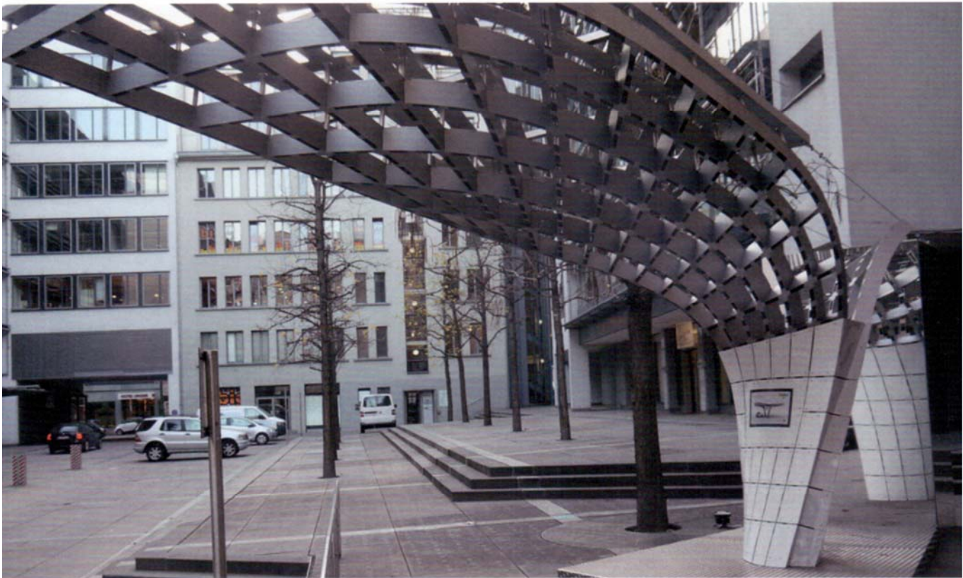
EIN ERSTER DEMONSTRATOR DER SOLARLADESTATION POINT.ONE IN STUTT GART
